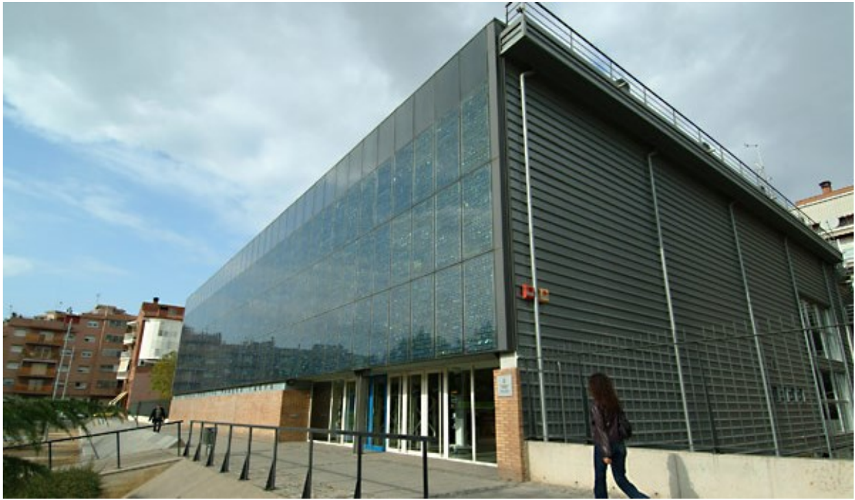
Figure 8.2 Pompeu Fabre Library Mataro. Design: Brullet i Tenas
