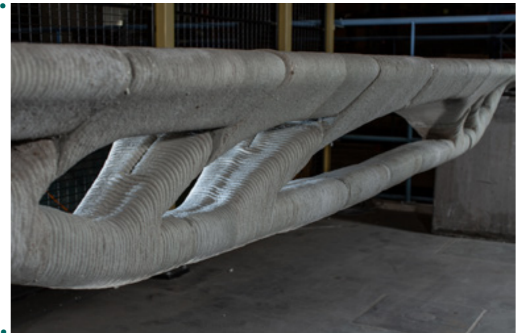
BETONNEN 3D-GEPRINTE BRUG FOTO VERTICO
