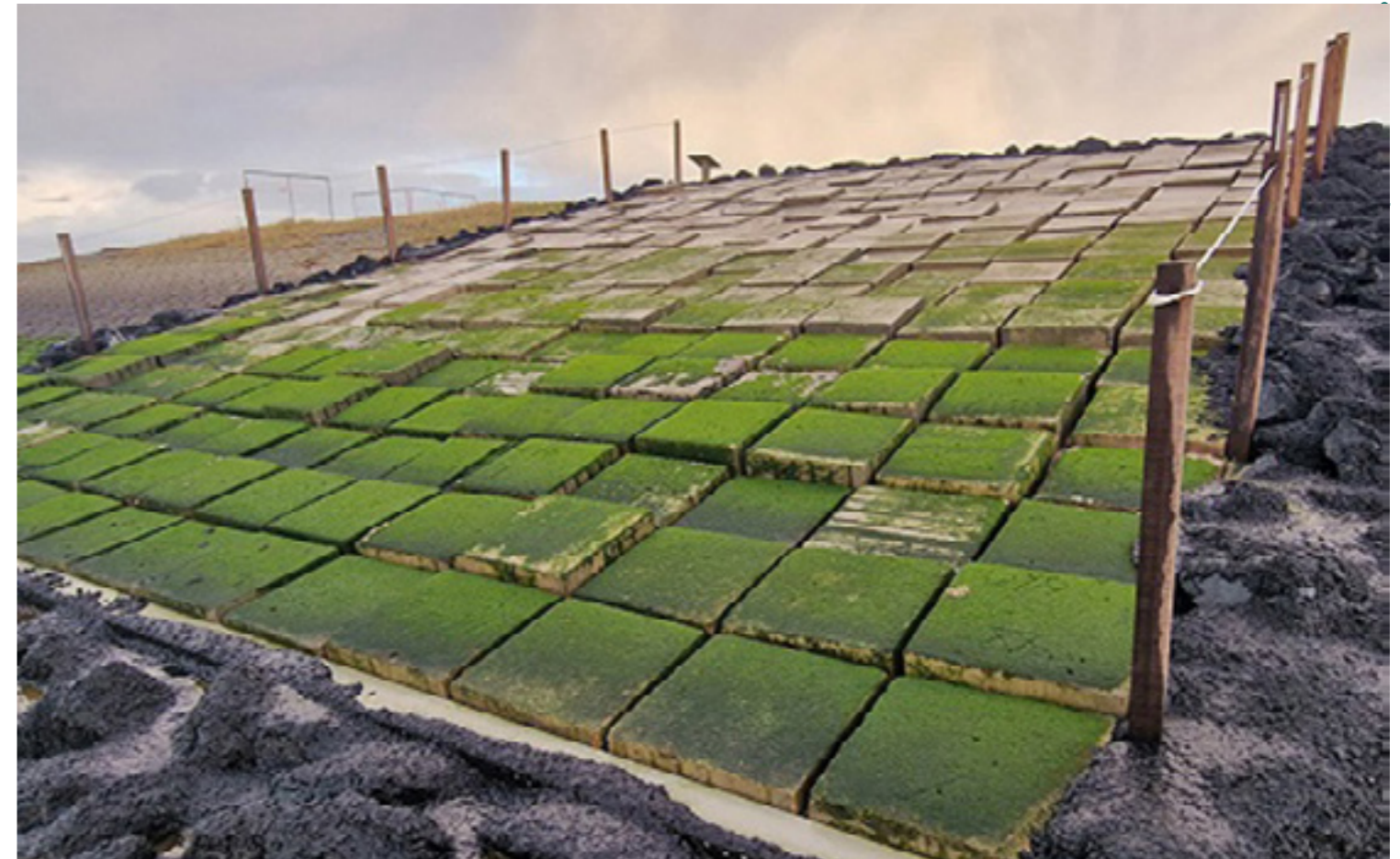
GEOWALL GEMAAKT VAN BAGGER FOTO NETICS
